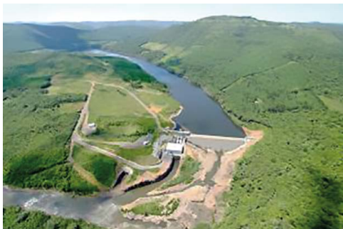
Figura 1: Vista aérea de pequena central hidrelétrica.
