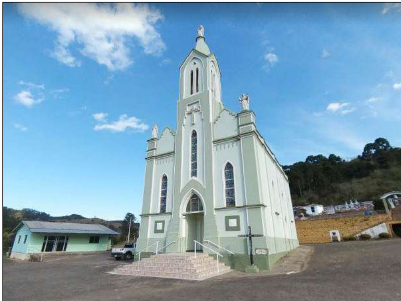
Foto 20: Igreja Matriz de Coqueiro Baixo.
